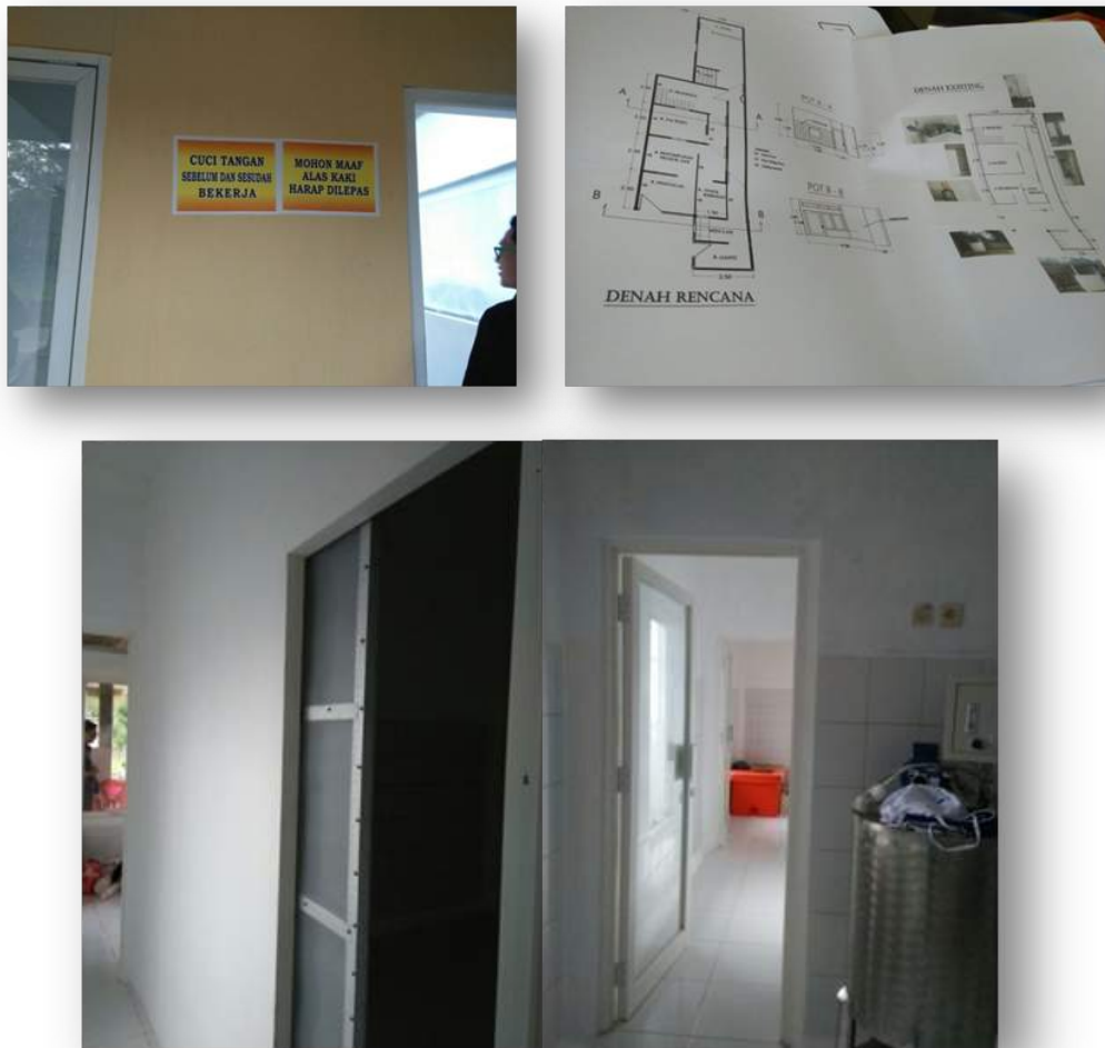
Gambar 16. Perkembangan Revitalisasi bangunan dalam rangka Fasilitas Peningkatan Mutu Produk Olahan, Kabupaten Boyolali Jawa Tengah
