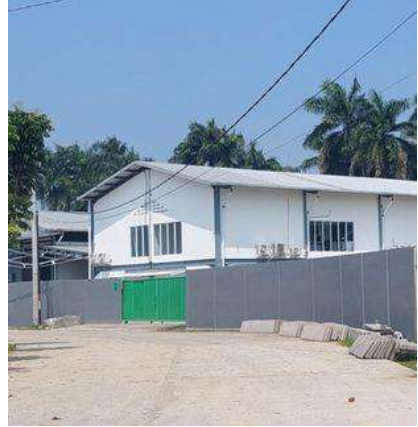
Gambar 4. Bebas genangan air di luar lokasi pabrik pakan
